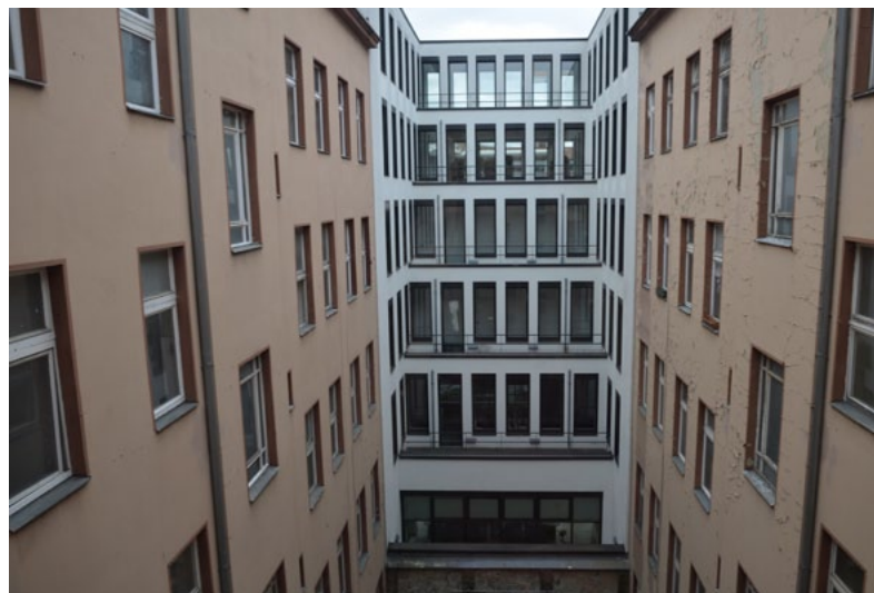
OBEN: Rodney LaTourelle, Chromakenón , 2012–13. Holz, Stahl and Autofarbe. 30 x 30 m UNTEN: Der Blick zum Hof von der Küche aus.
