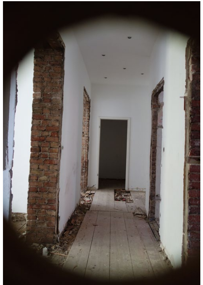
Ein Blick durch einen Türloch in eine entkernte Wohnung.
